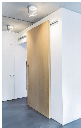
/ Lediglich die Laufschiene des wandintegrierten Beschlages ist zu sehen.
